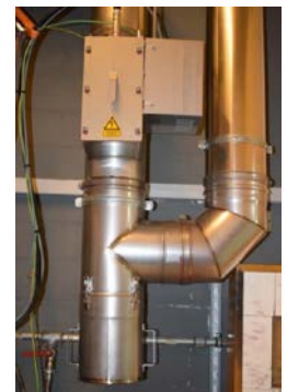
Vertikaler Einbau mit Staubsammelbox (s. Bild 1)
